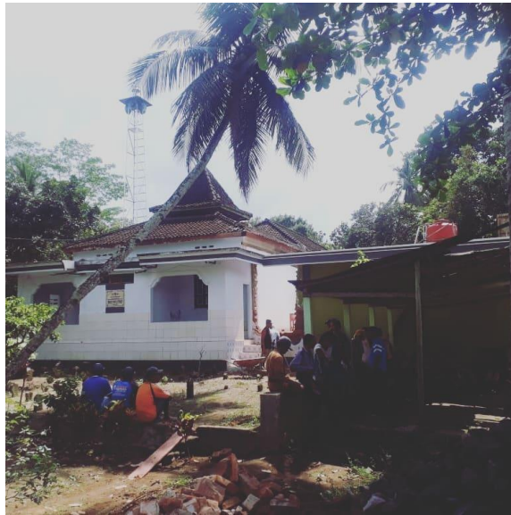
Gbr 4.1 Dokumentasi Masjid Darul Kurmain Sebelum Renovasi
