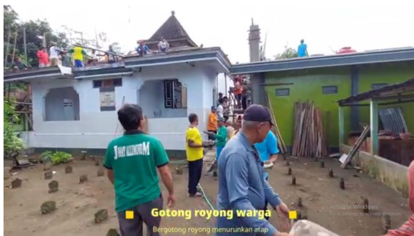
Gbr 4.2 Dokumentasi Gotong Royong Renovasi Masjid Darul Kurmain
